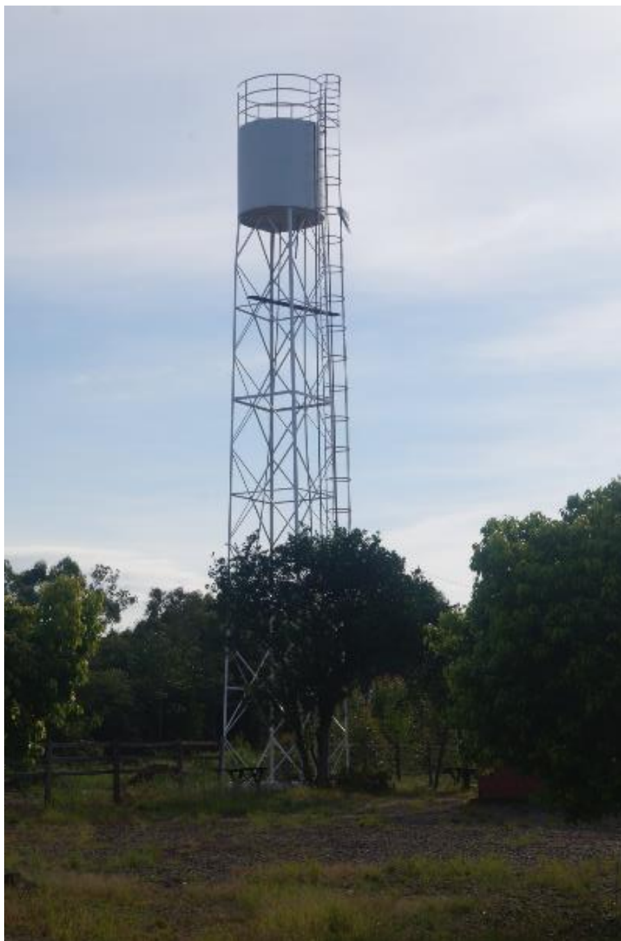
Figura 41. Reservatório de Pedra Grande.
