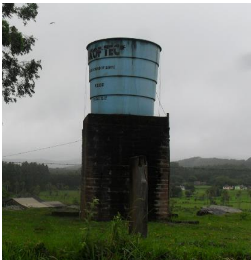
Figura 50. Reservatório de Cabriúva.
