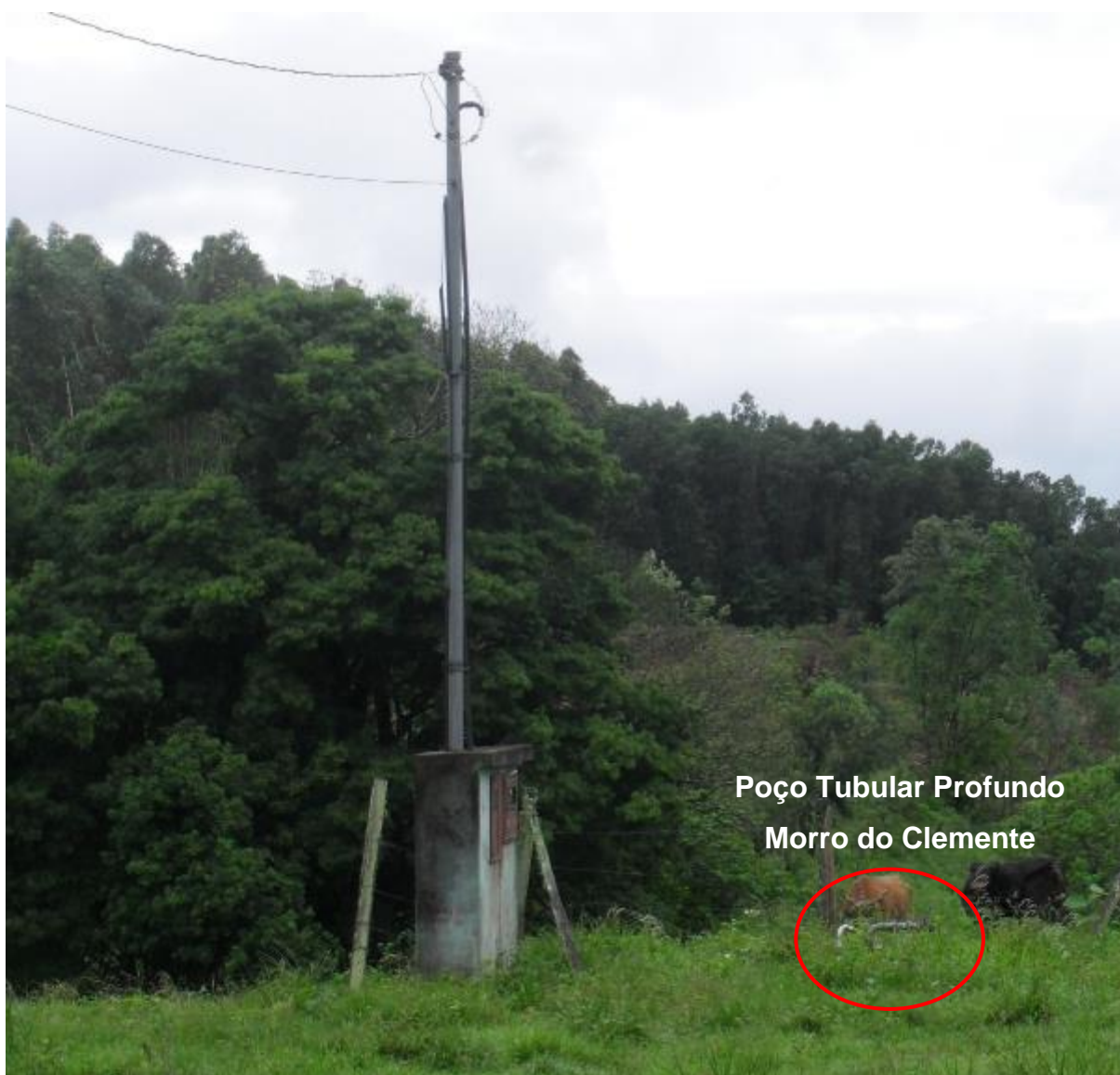
Figura 37. Poço Morro do Clemente
