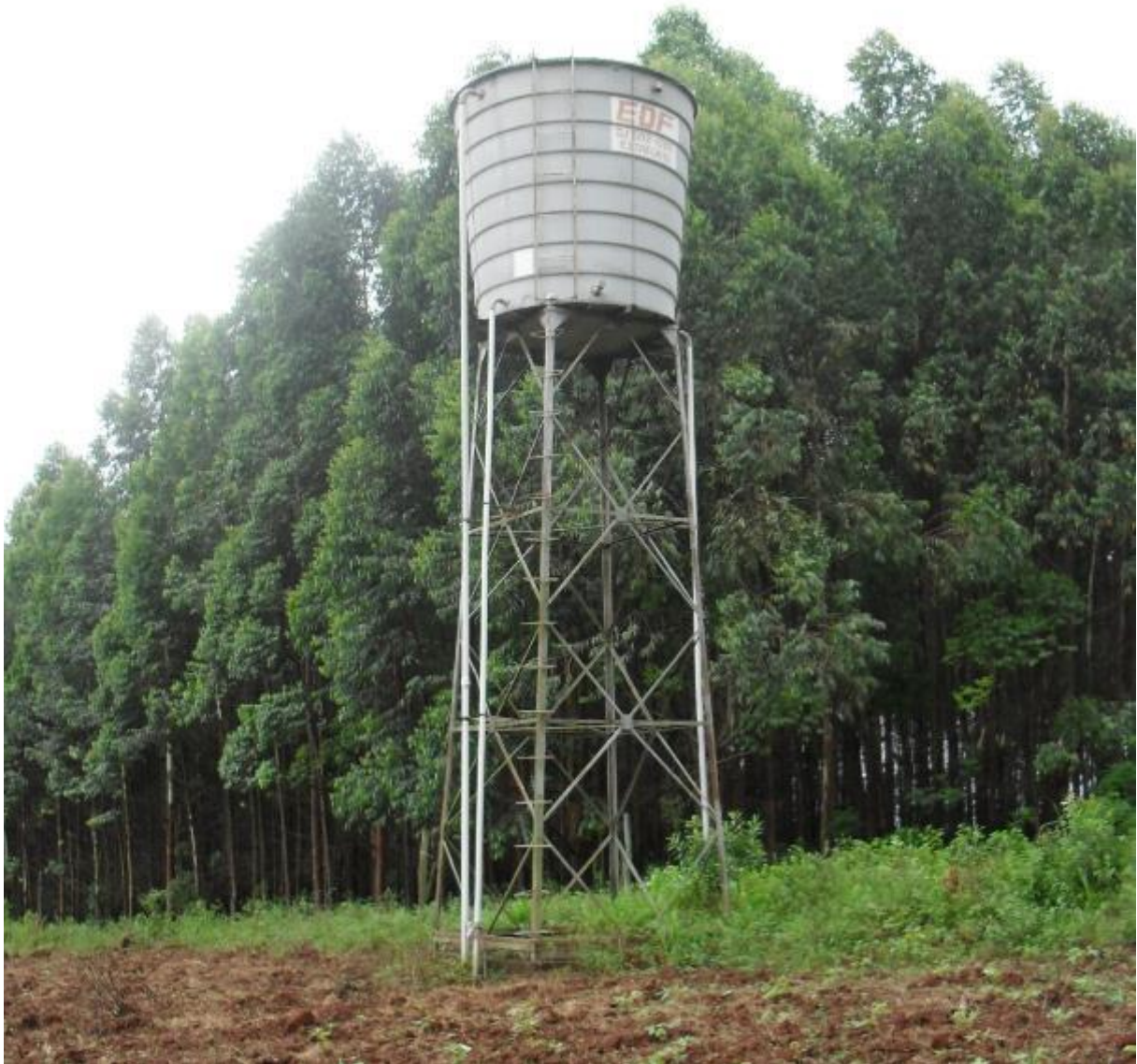
Figura 38. Reservatório do Morro do Clemente.
