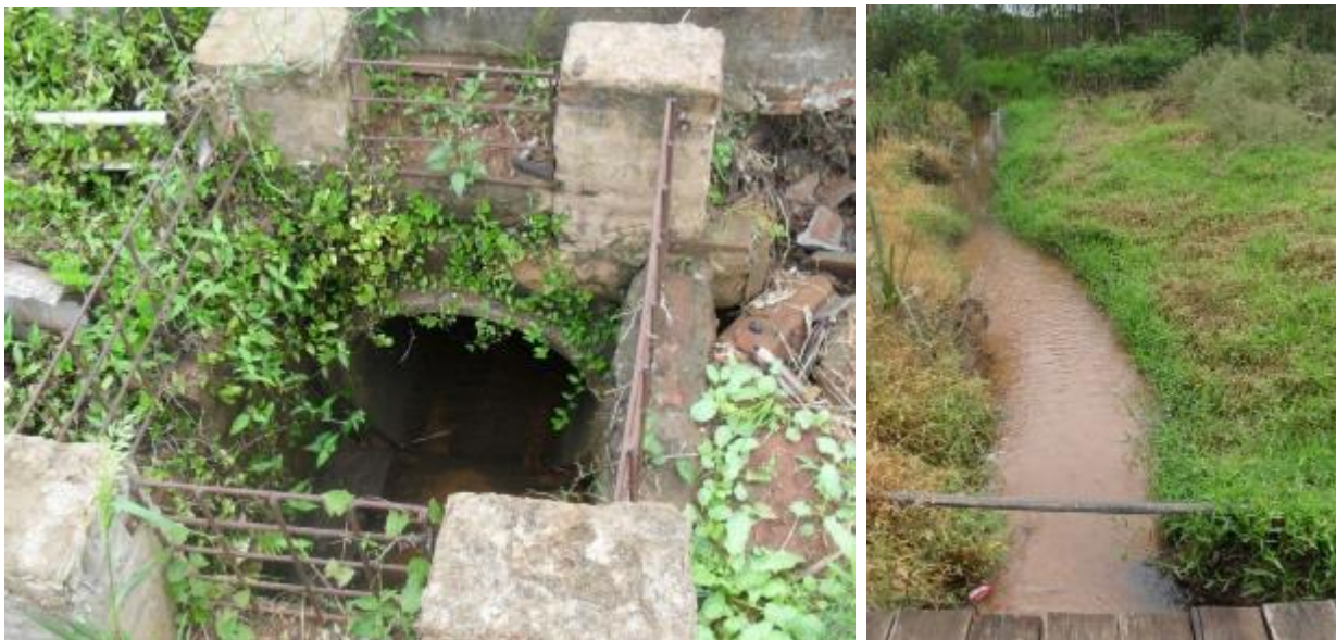
Figura 66. Exemplo de microdrenagem (foto da esquerda), e macrodrenagem (foto da direita) de Tabai.
