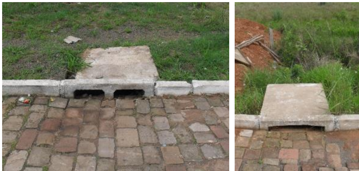
Figura 65. Exemplos de bocas-de-lobo do município de Tabai.
