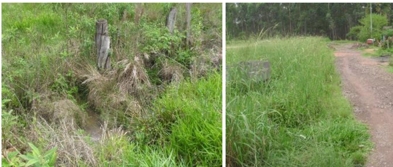
Figura 72. Saída da vala de drenagem pluvial, que recebe esgoto cloacal (à esquerda), e rua próxima ao ponto de alagamento (à direita).
