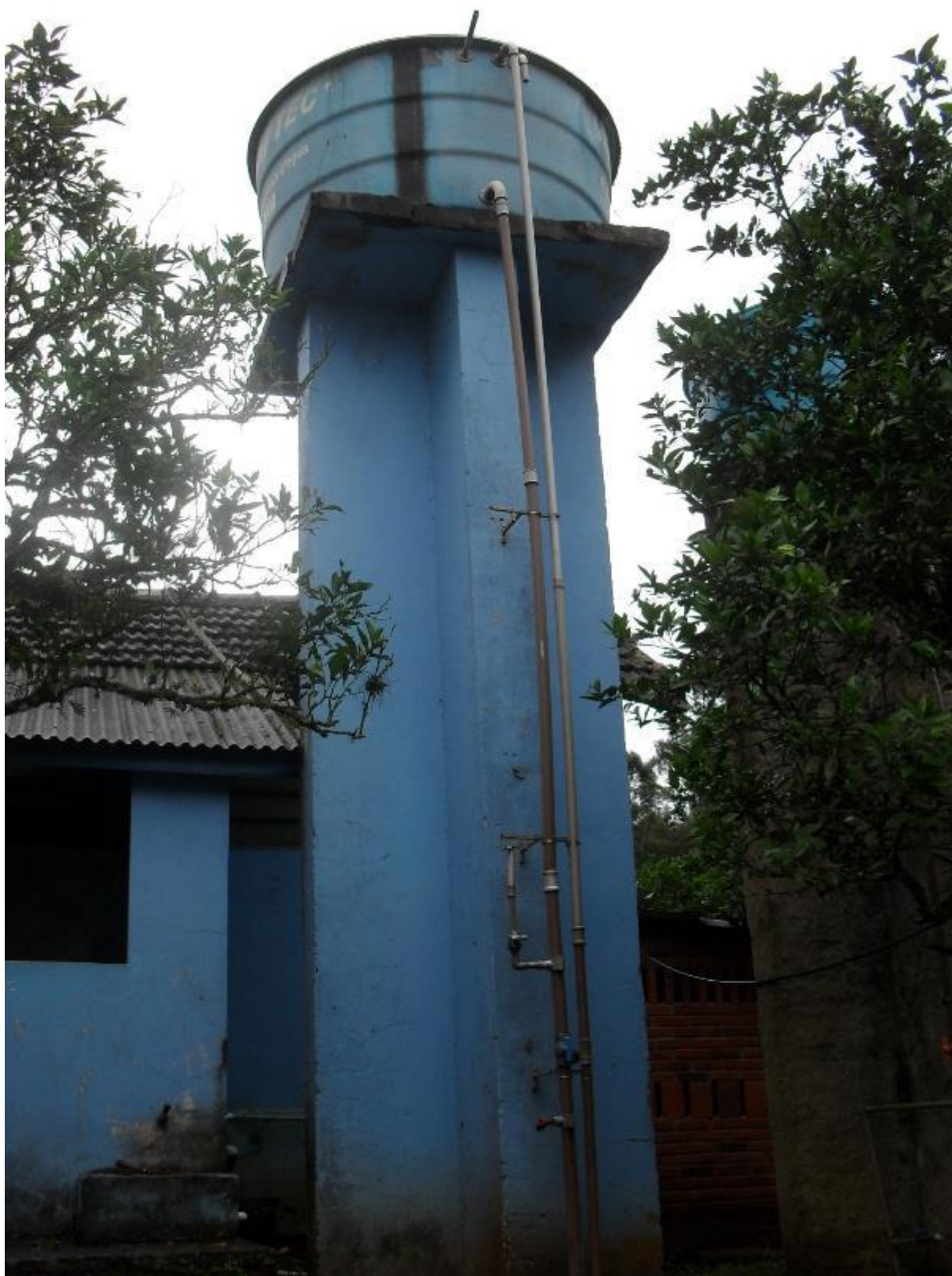
Figura 47. Reservatório da Vila Tabai.
